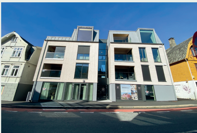
Fasaden mot Skjoldaveien i sør er designet for å stå i stil med gatas eldre trehusbebyggelse.
